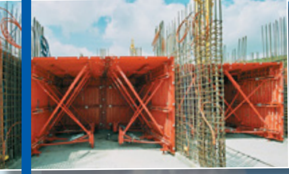
Tünel kalıp sistemi
