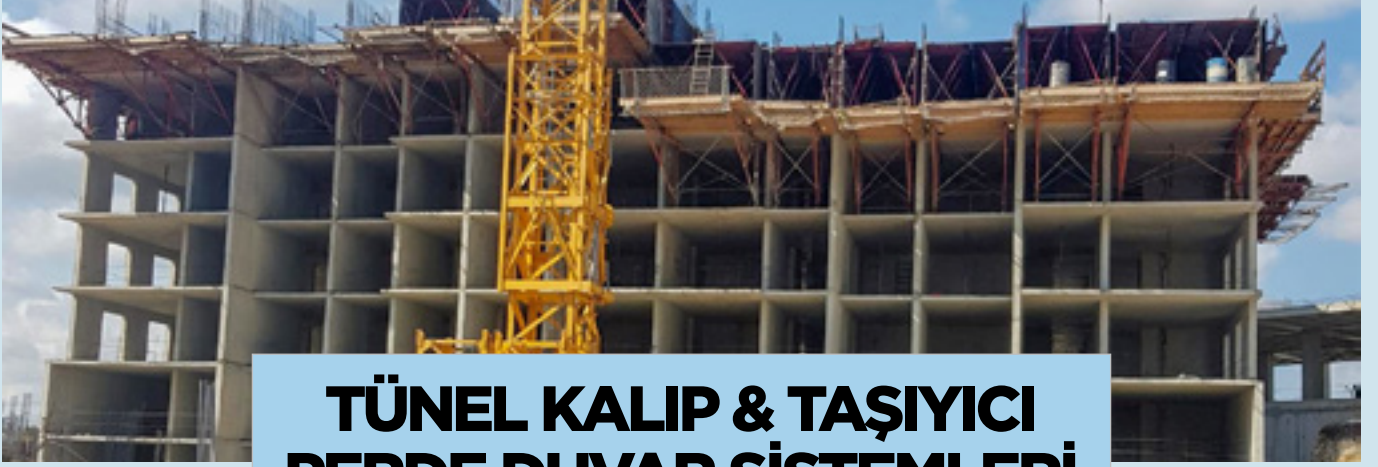
Tünel kalıp uygulaması
