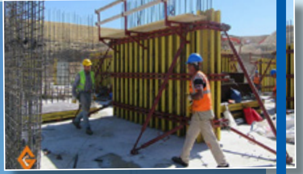
Taşıyıcı perde duvar sistemi
